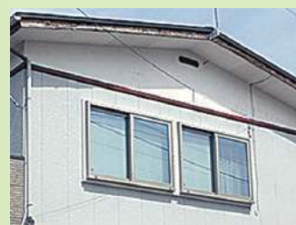
リフォーム後 （志村建設㈱提供）
