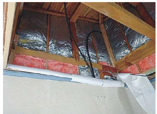
気流止めにより壁の断熱性能を 向上させる部位リフォームの例 (小松工務店提供)
